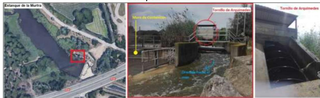
Imatge 40. Sistema de drenatge a l'estany de la Murtra. Caragol d'Arquimedes en funcionament després d'un episodi de pluja
