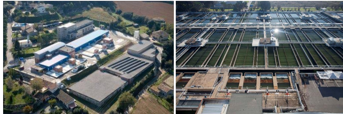
Imatge 97. Planta potabilitzadora de Cardedeu
