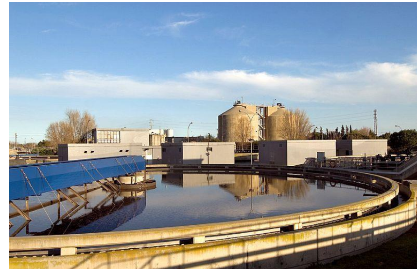
Imatge 332. Depuradora de Gavà-Viladecans
