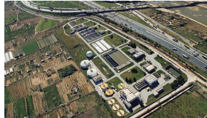
Imatge 334. Depuradora de Sant Feliu de Llobregat
