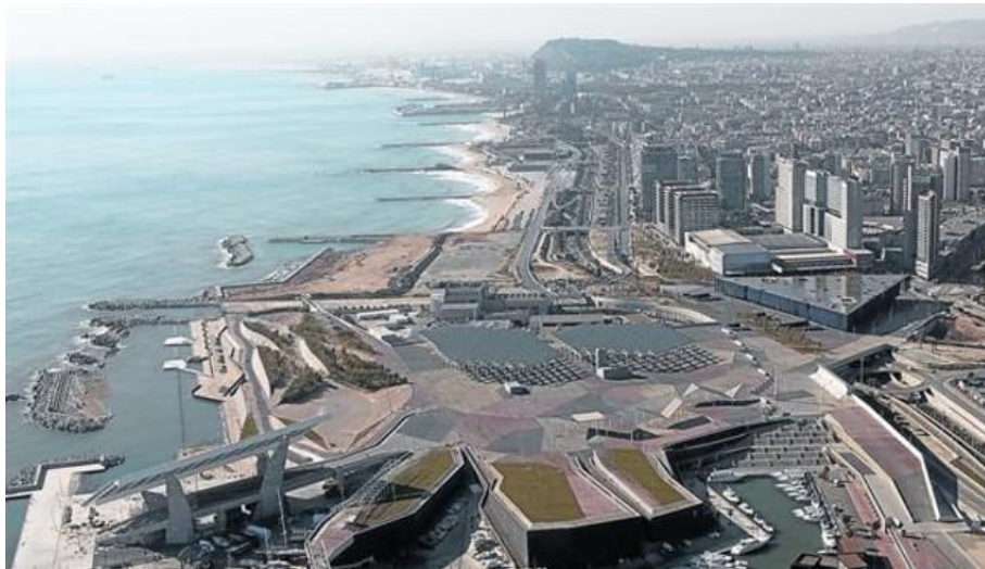
Imatge 330. Depuradora del Besòs
