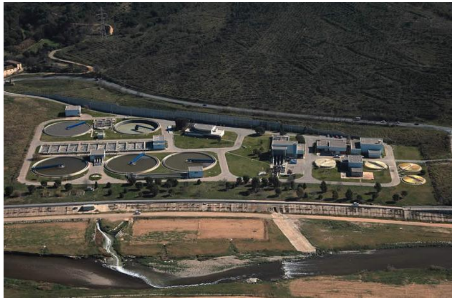
Imatge 333. Depuradora de Montcada i Reixac
